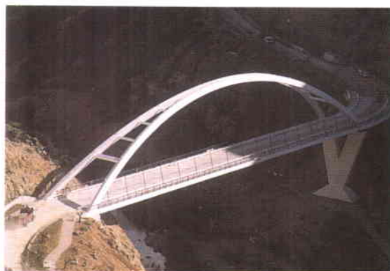
Puente de Millares.
